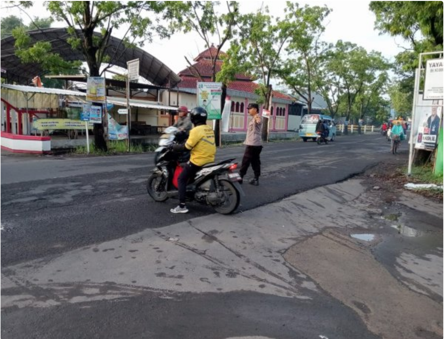
KAB. CIREBON - Depan SDN 2 Kepongpongan Kec. Talun Pengaturan lalu
